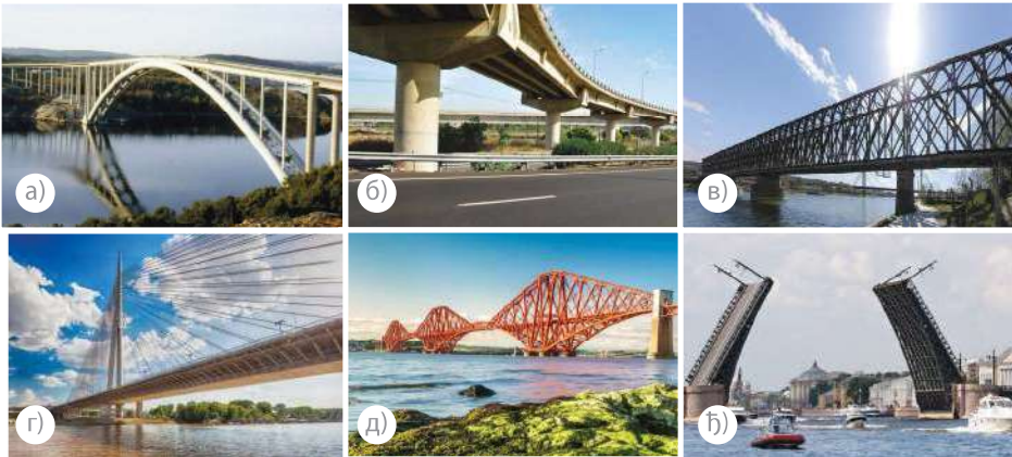
Сл. 2.10. Врсте мостова према конструкцији: (а) лучни, (б) гредни, (в) решеткасти, (г) висићи, (д) конзолни, (ђ) покретни
