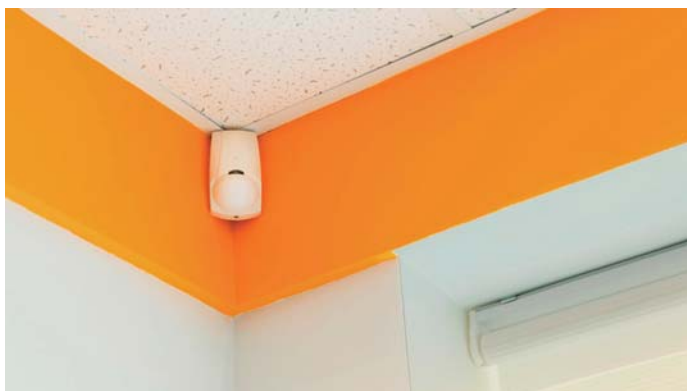
Slika 1-6. Tipičan senzor loma stakla
